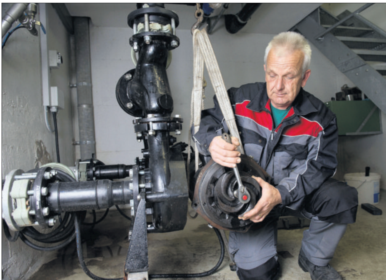
Klärwärter Valentin Bütler reinigt eine verstopfte Pumpe bei den Pilatus-Flugzeugwerken.
