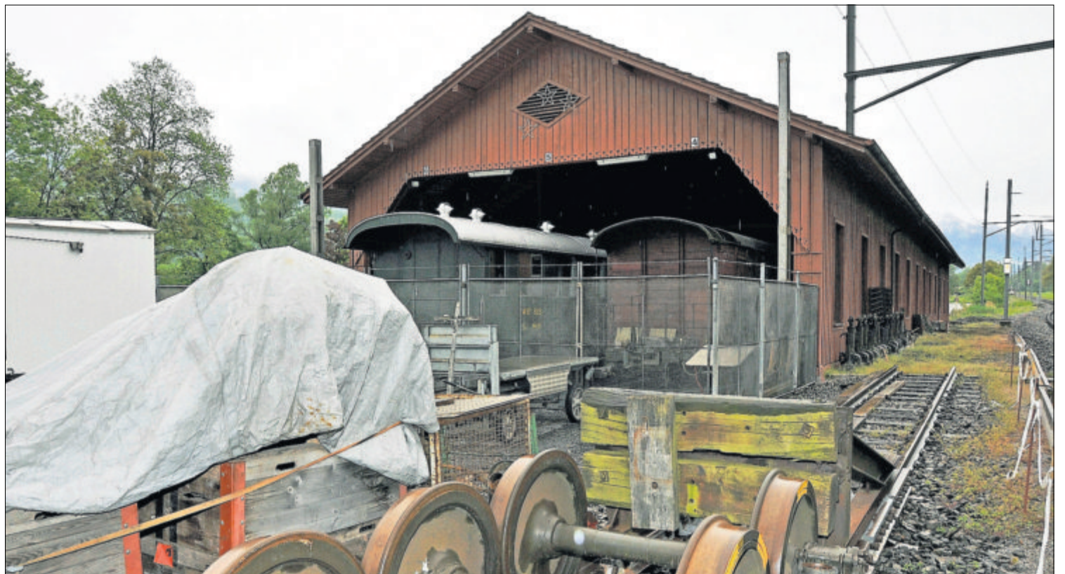
Ein Teil des Vereinsmaterials von ZB Historic ist inner- und ausserhalb der Remise beim Bahnhof Alpnachstad untergebracht. Bild Robert Hess
