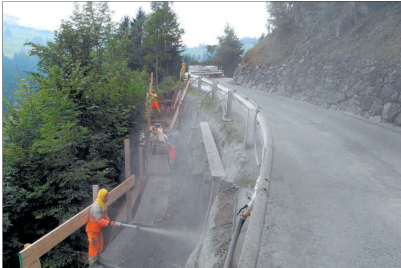
An der Wiesenbergstrasse wird seit ein paar Tagen wieder gearbeitet.
