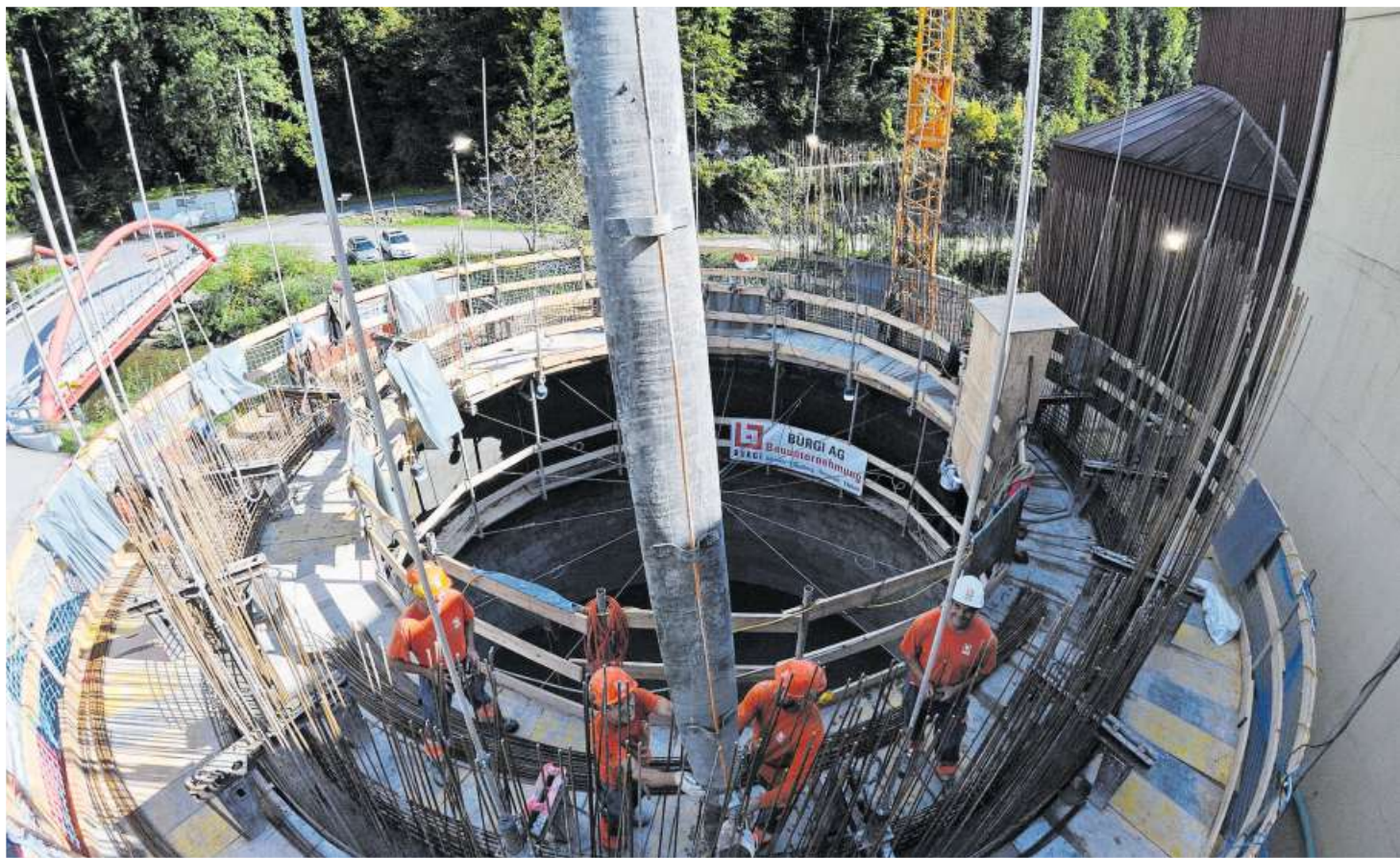
25 Zentimeter pro Stunde wuchs der Betonturm seit Dienstag bei der ARA.
